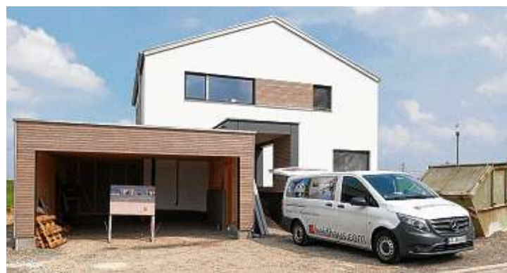
Durch die großzügige Hauseingangsüberdachung können die Bewohner direkt von der Garage in das Haus gelangen.
