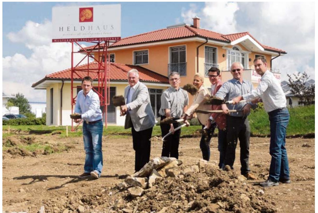
Das Unternehmen Held Haus in Löffingen feierte jetzt den Spatenstich für die firmeneigene Abbundhalle. Mit von der Partie waren (von links) der zukünftige Produktionsleiter Bertram Spannagl, Bürgermeister Norbert Brugger, Statiker Benni Knöpfle, Ingrid und Roland Held, Architekt Jürgen Köpfler und Mitarbeiter Ronald Spielberg. BILDER: BUTSCHLE
